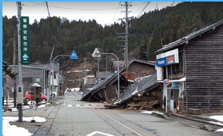
地震直後の輪島市三井地区
